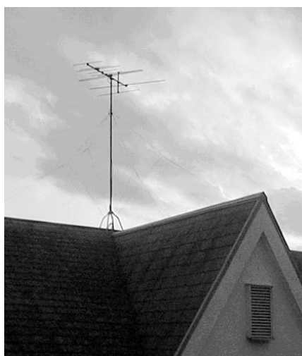
図 21 屋根にTV用八木アンテナ
