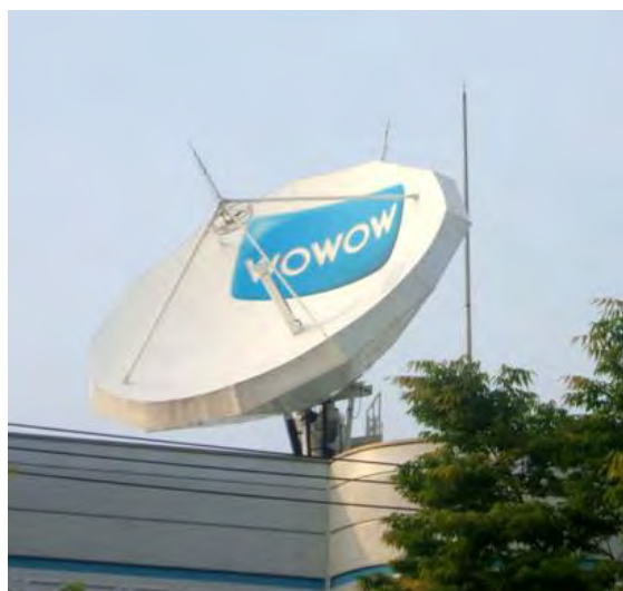
図 25 WOWOW の通信衛星に向けて電波を送信する都内にあるパラボラアンテナ 直径 8m?
